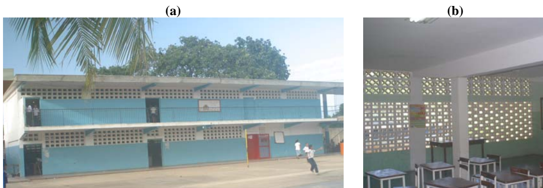
Figura 2.1. (a) Fachada longitudinal del G. E. Manuel M. Urbaneja; (b) Vista interior del pórtico transversal del G. E. Petrica R. de Quilarte. Ambas son del Tipo Antiguo I y fueron dañadas durante el sismo de Carúpano de 1.974. Las fotos fueron tomadas en el año 2.008.
