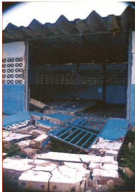
Figura 2.7. Volcamiento de paredes de relleno en el Grupo Escolar Matías Parra Alcalá en Casanay durante el sismo de Cariaco de 1.997 (cortesía FEDE).
